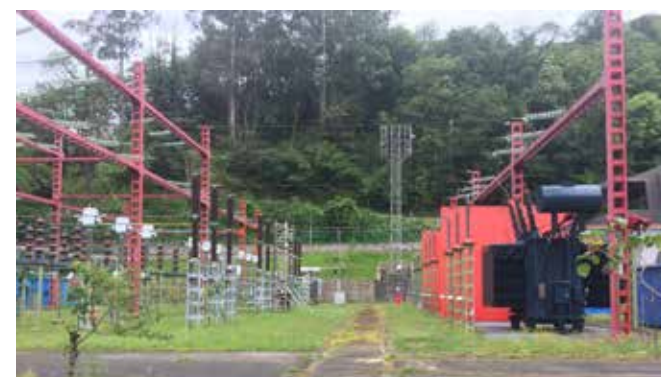
Poste électrique de Soullans (en haut)
