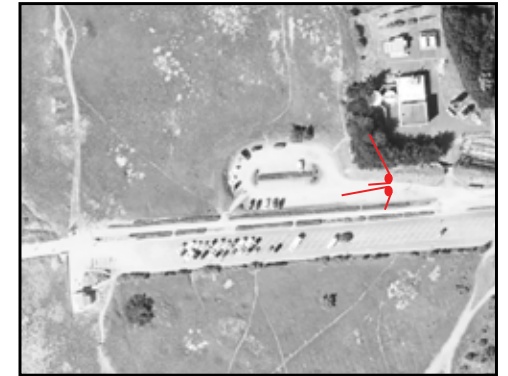
Localisation : Route de la Grande Côte - passé la station d'épuration
