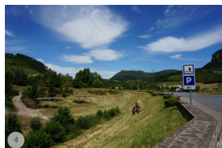
4 Aire aménagée avec vues sur les infrastructures de transport (D999 lignes et poste de transformation).
