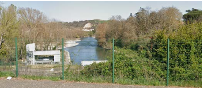
Franchissement de la Garonne et vue sur la centrale hydroélectrique
