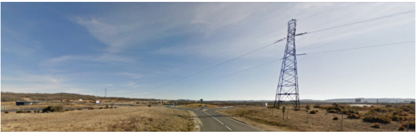
La ligne traverse La Méridienne A65, au carrefour des 4 communes de Sainte-Eulalie-de-Cernon, Cornus, l'Hospitalet du Larzac et la Couvertorade. Vue depuis l'échangeur.
