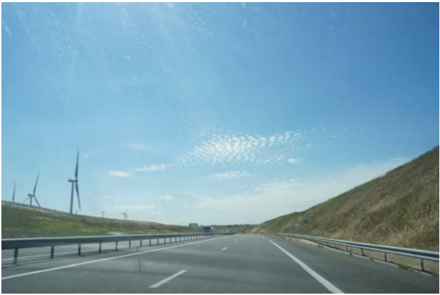
Les projets éoliens sur le Causse du Larzac, placés à proximité de la Méridienne A75, rythment le trajet en apportant de la verticalité.
