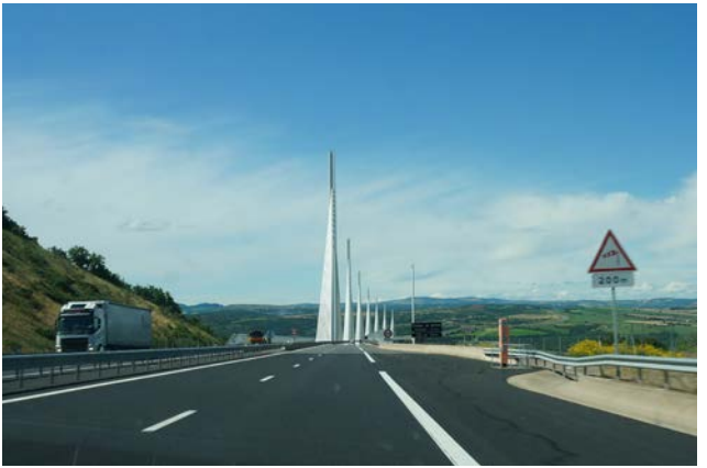
Le Viaduc de Millau, une infrastructure mise en exergue dans le paysage de la vallée du Tarn et du Millavois.
