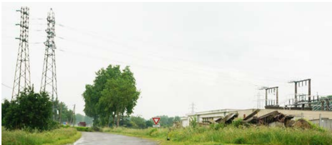
Les abords concentrent des déchets stockés ( pylônes béton )
