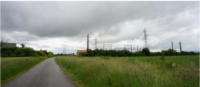
Arrivée progressive sur le poste de Boulbonne par le chemin d'Ampouillac
