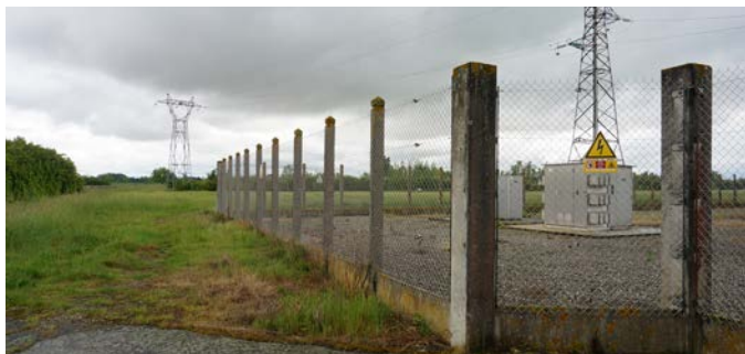
Aucun traitement des abords et limites du poste n'est perceptible
