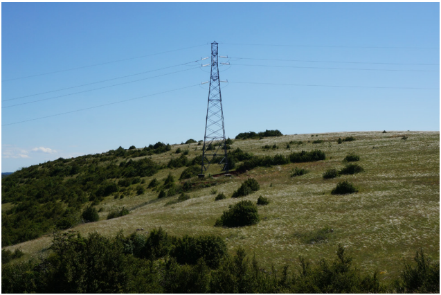
La ligne RTE traverse le relief du Causse du Larzac et crée des repères verticaux très visibles.
