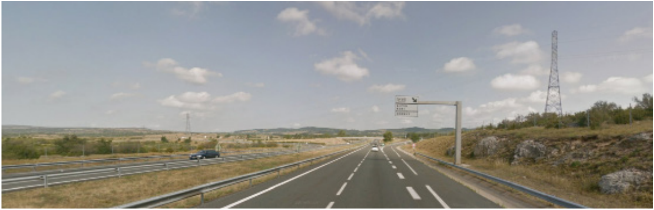
Vue de la ligne à raccorder depuis l'autoroute A75 en direction de Millau. L'inscription de cette infrastructure autoroutière est intéressante, et contraste avec celle de la ligne haute tension.
