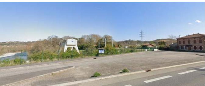
Aperçu de la centrale hydroélectrique depuis la RD627
