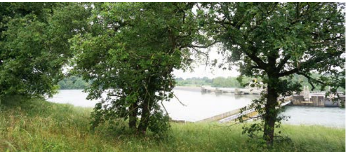
Découverte du barrage de Manciès, une infrastructure d'envergure mais non visible ( point de vue depuis un parc privé )
