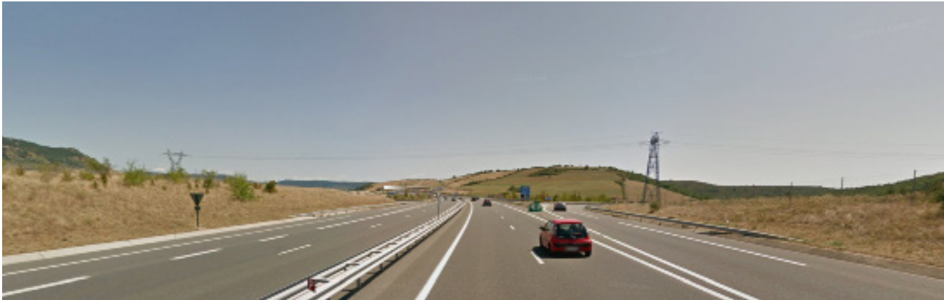
Vue de la ligne à raccorder depuis l'autoroute A75 en direction de Millau. Un travail d'inscription des lignes à haute tension, à la fois par le positionnement et le design aurait pu être effectué pour aller dans le sens d'une démarche paysagère cohérente.
