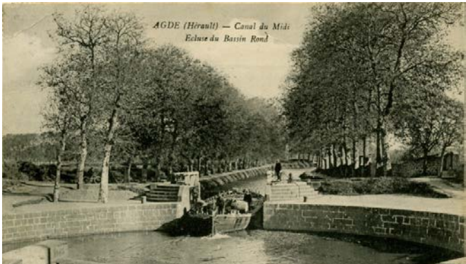
L'écluse du bassin rond, canal du midi ( 34)
