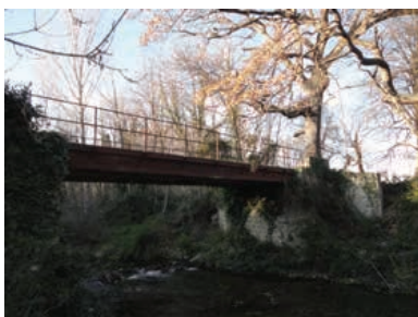
Pont de l'Argent-Double
