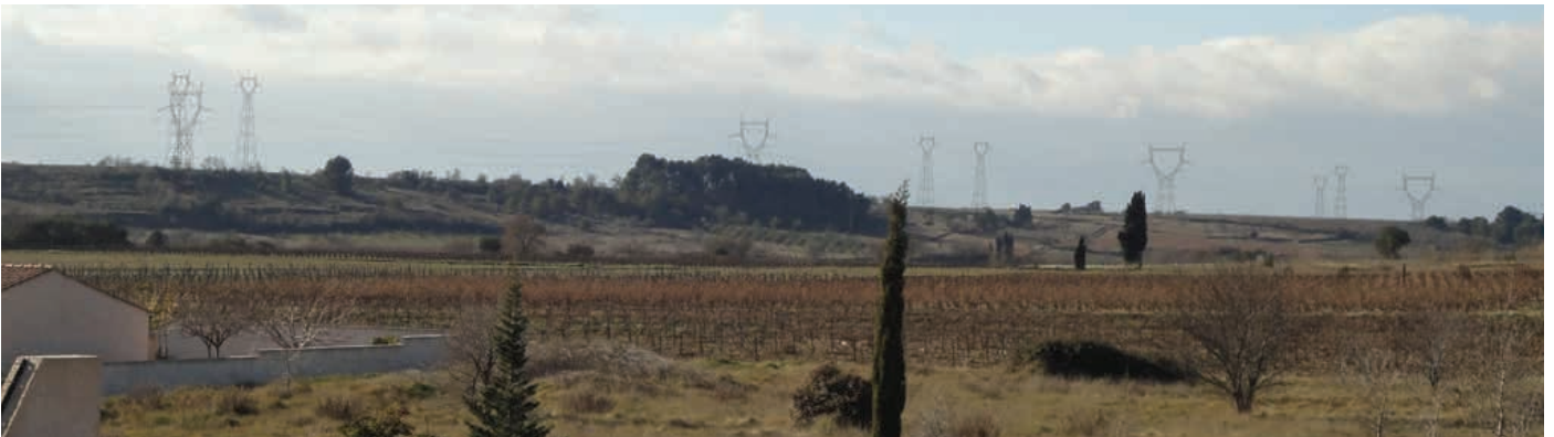
Le réseau électrique de l'axe est-ouest vu au niveau du quartier des 4 vents situé à la périphérie ouest de la ville.
