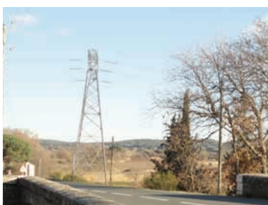
Pont entrée Est de La Redorte (pylône n° 3 de la Méridienne)
