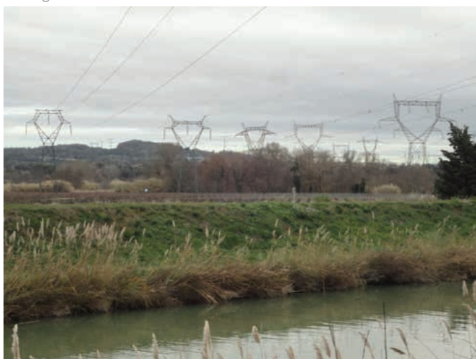
Réseau électrique de l'axe est-ouest traversant le Canal au sud de la commune.
