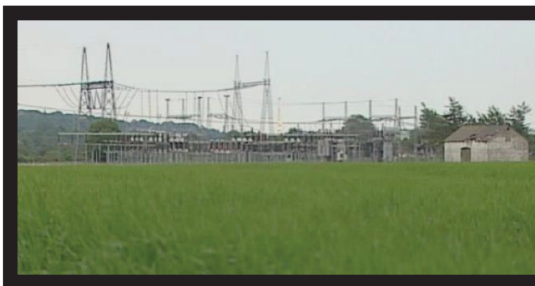
Poste aéro souterrain au Danemark.
