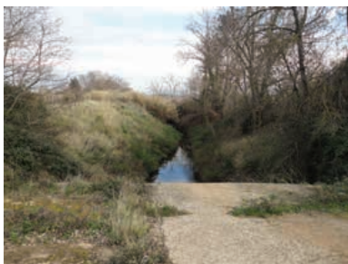
Pont-canal du Rivassel
