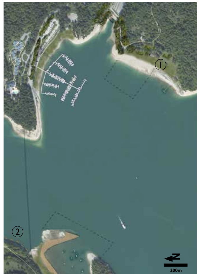
Le site de Mercantine se situe dans la séquence sur l'eau. Il propose une traversée entre les deux rives. Cette expérience offre un regard et une position nouvelle sur le lac. L'espace face à la plage évolue en fonction de la fluctuation de la côte, formant une crique puis une plage. ▲
